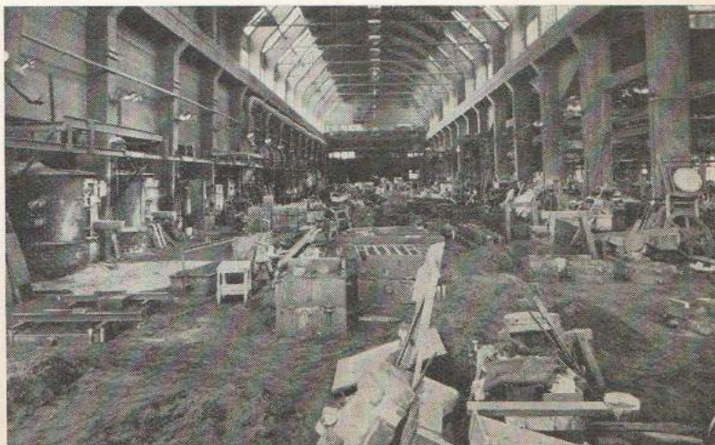
A.-B. Bolinder-Munktell. Interiör från stora gjuterihallen.
