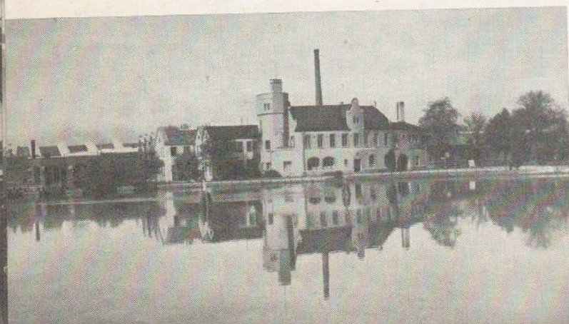
A.-B. Bolinder-Munktells kontorsbyggnad i Eskilstuna.
