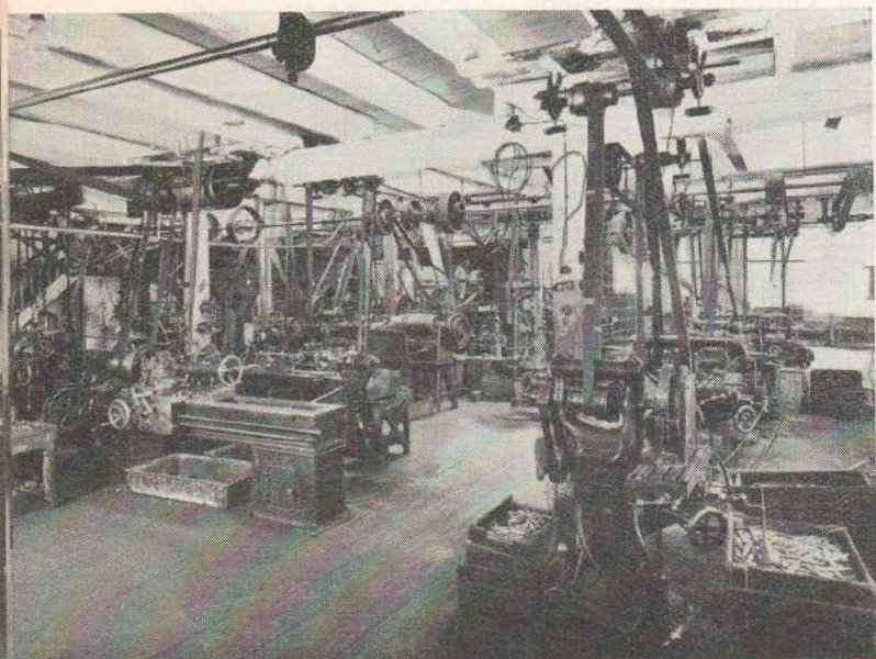
Interiör från firma Eminentverktyg. En av maskinsalarna.
