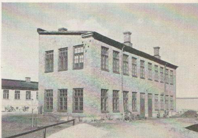
Exteriör av C. M. Fall & Sons fabriksbyggnad.
