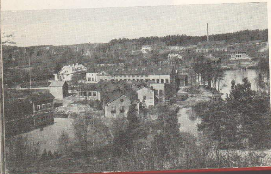
Exteriör av fabriksan- läggningarna vid Rosen- fors.
